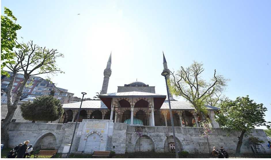
Şekil 7. Üsküdar Mihrimah Sultan Cami Genel Görünüm
