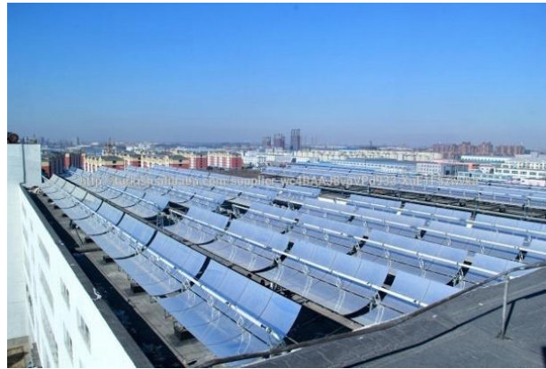
Şekil 3. Çatıya kurulu parabolik oluklar
