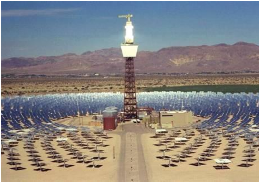
Şekil 5. Solar ısı güç kule santrali
