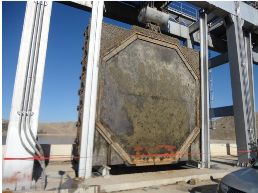
Şekil 2. Cebri boru giriş kapağı
