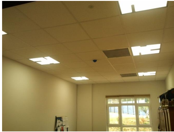
Şekil 3. Oda 3 için LED Armatür Yerleşimi
