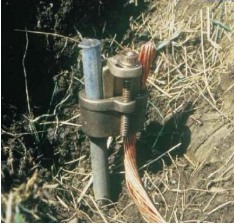
Şekil 4. Topraklama çubuğuna topraklama iletkeninin bağlanması
