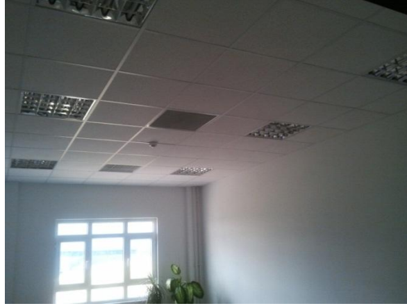
Şekil 2. Oda 1 ve Oda 2 için Flüoresan Armatür Yerleşimi
