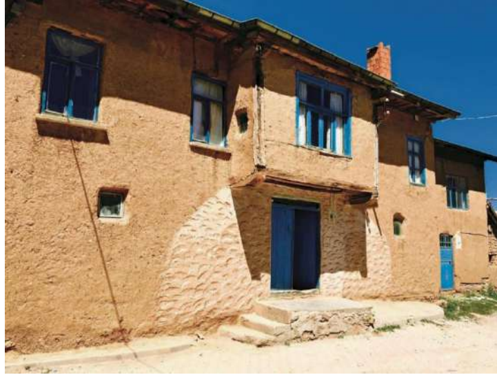
Şekil 1. Konya-Hüyük Köyü'nden bir kerpiç yapı örneği (Karakul, 2019)
