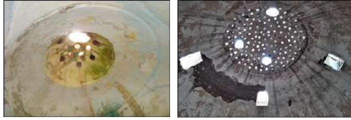
Şekil 5. Deva Hamamı sıcaklık, ılıklik ve halvet bölümlerinde fil gözlerindeki malzeme kayıpları (Aralık 2019)
