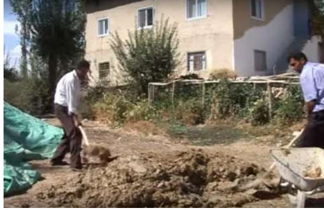
Şekil 2. Kerpiç elde etmek üzere samanla karıştırılan toprak (URL 1)
