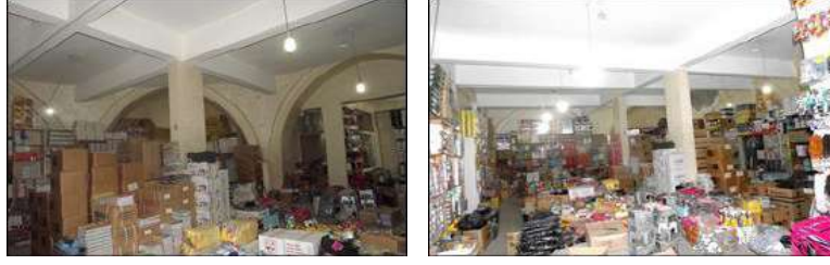
Şekil 3. Melik Ahmet Paşa Hamamında niteliksiz onarım sonrası oluşan hasarlar (Aralık 2019)
