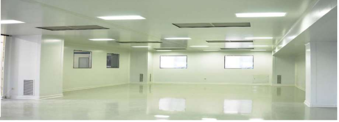
Şekil 4. Temiz Odanın Zemin Yüzeyi Pürüzsüz Olmalı
