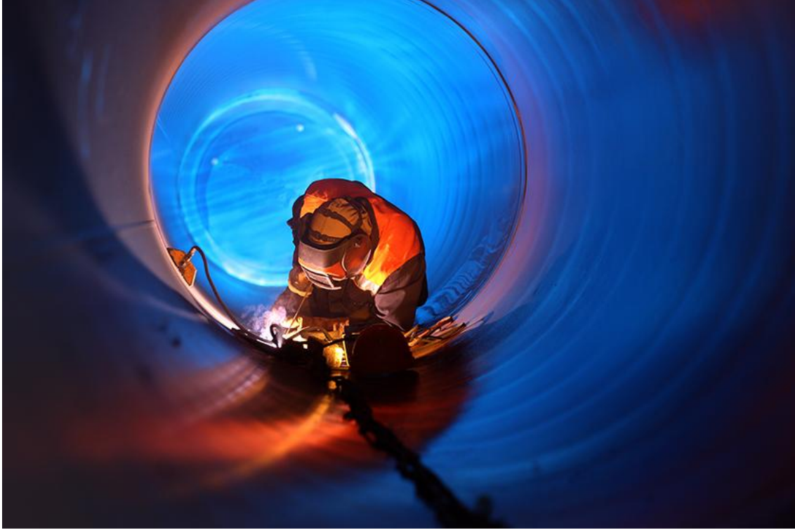
Fotoğraf 3. Boru kaynağı yapımı
