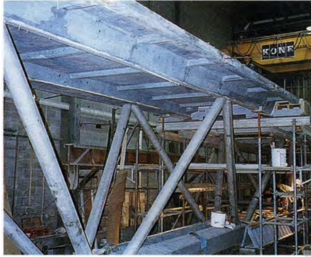
Şekil 1. Sherbrooke köprüsünün RPB ile üretim aşaması
