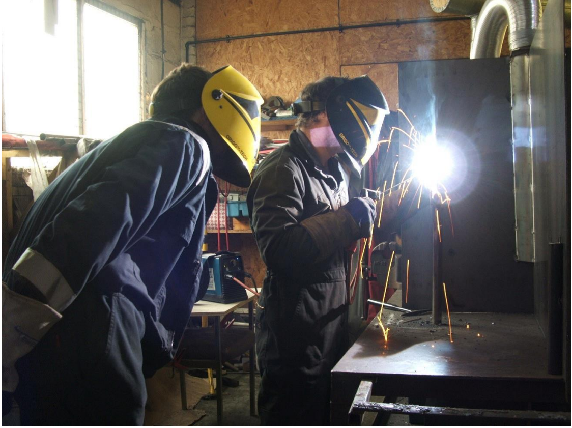
Fotoğraf 1. Elektrik ark kaynağı uygulaması
