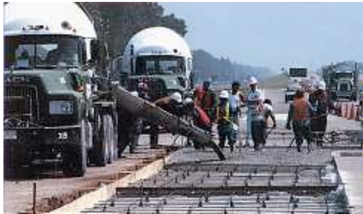
شکل 1-9: استفاده از ژئوپولیمیر در ایالات متحده آمریکا در پروژه های راهسازی
