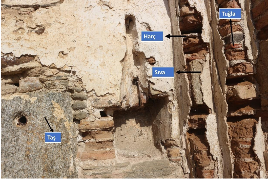
Görsel 4. Çeşme Binası, Yapı Malzeme Detayları.
