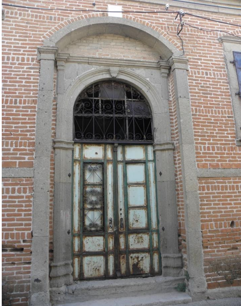
Fotoğraf:2- Ahmet Dalgıç Konağı Giriş Eyvanı.
