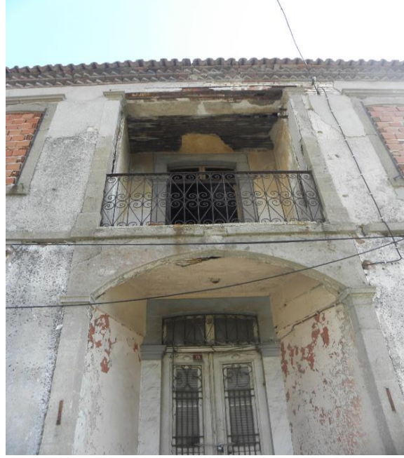
Fotoğraf:4- Hakkı Öktem Konağı Giriş Cephesinden.
