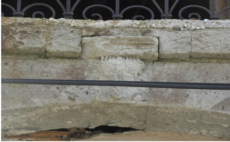
Fotoğraf:6- Hakkı Öktem Konağı Giriş Eyvanı Kemer Kilit Taşında Kenger Yaprağı Motifi.
