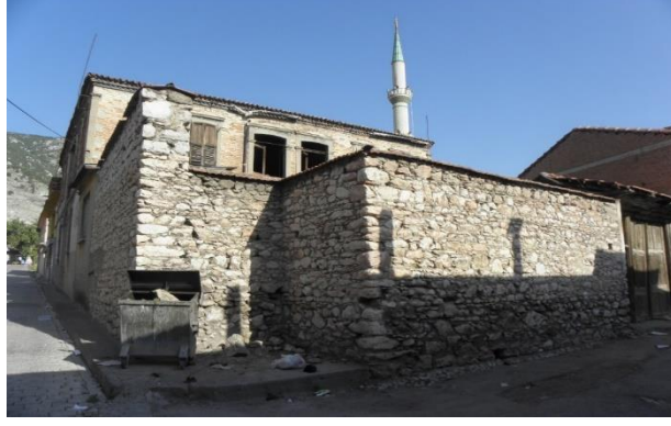
Fotoğraf:2- Hakkı Öktem Konağı Bahçe Cephesi ve Bahçe Duvarları.
