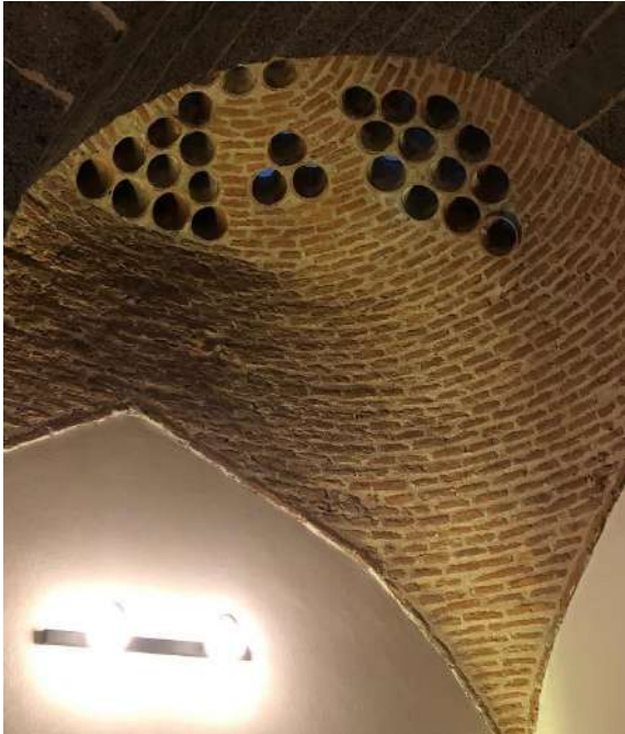
Fotoğraf 20: Kubbede bulunan fil gözleri
