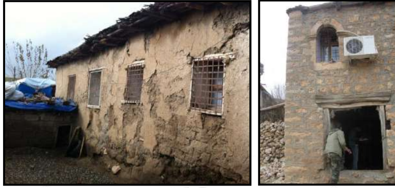
Şekil.2.5 Kapı ve pencerede ahşap hatıl kullanımı
