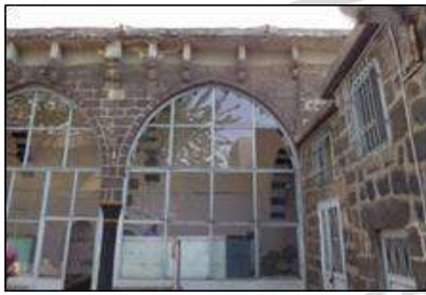
Şekil 12. Hoca Ahmet Paşa Camideki beton döşemeye bağlı oluşan hasarlar
