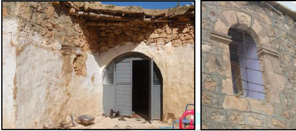
Şekil.2.3 Kapı ve pencerede kemer kullanım örneği
