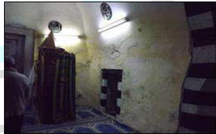
Şekil 19. Hoca Ahmet Camisinde Bakımsızlığa Bağlı Oluşan Nem ve Ayrışma Hasarları
