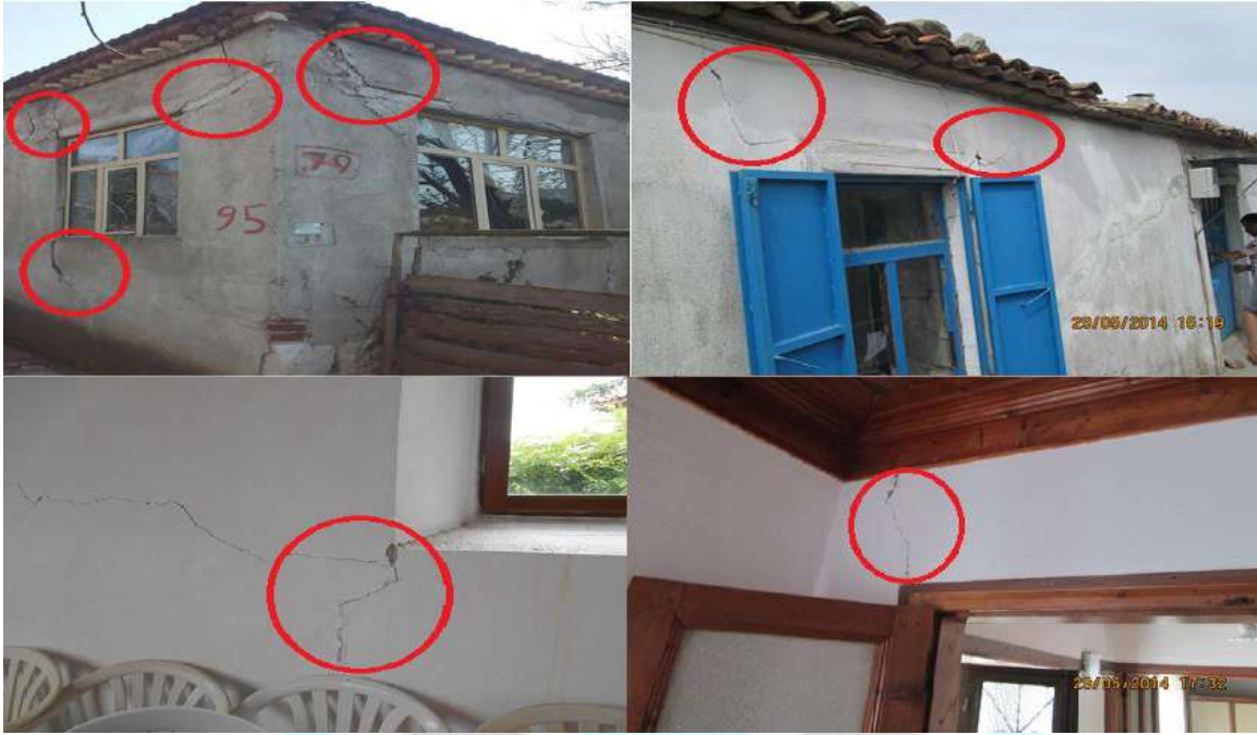
Şekil 5. Boşluk bölgelerinde gözlemlenen hasarlar
