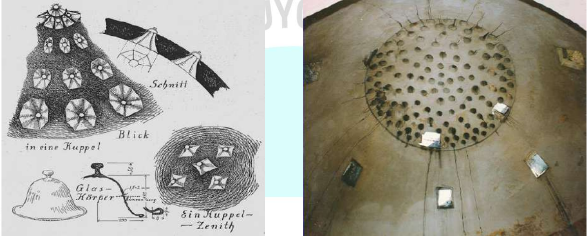
Şekil 1. Fil gözlerinde kullanılan cam vantuzların detayı (Klinghardt, 1927)
