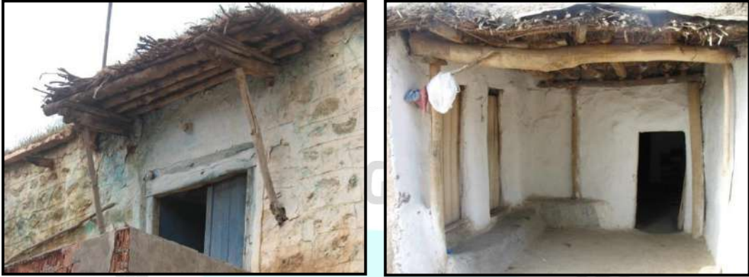
Şekil.2.10 Saçak elemanı olarak ahşabın kullanımı
