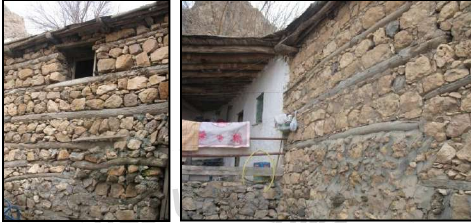
Şekil.2.8 Duvarlarda ahşap hatıl kullanım örnekleri
