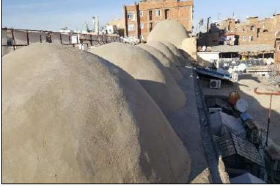
Şekil 25. Hasan Paşa Kullanıcıya Bağlı Oluşan Çatlak Hasarı
