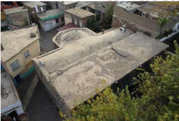
Şekil 2. Minareden Görünüşü caminin dam görünüşü
