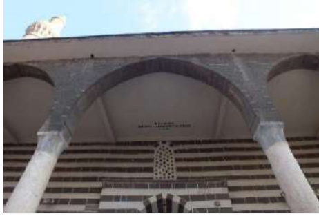
Şekil 5. Üst Örtüsü betonarme ile değiştirilen İskender Paşa
