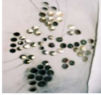
Şekil 15. Çardaklı Hamamı sıcaklık mekanı ışık tavanı
