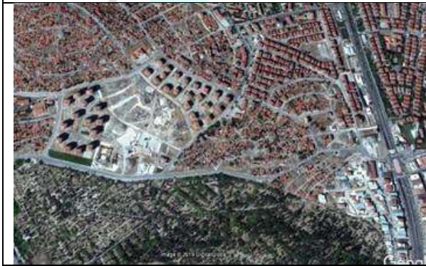
2012- Gecekondu yıkımı etap halinde devam etmektedir
