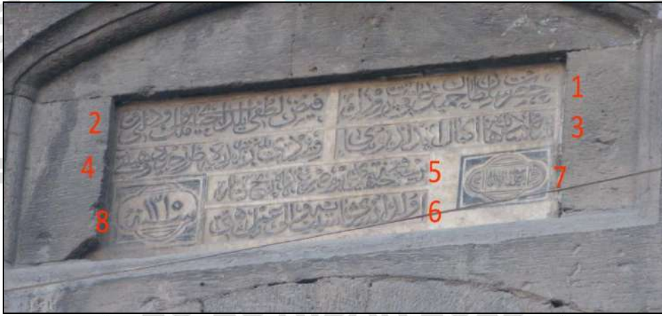
Şekil 4. Giriş kapısı üzerindeki kitabe (2006)
