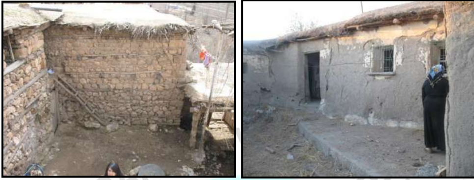
Şekil.2.7 Üst örtü (toprak dam)
