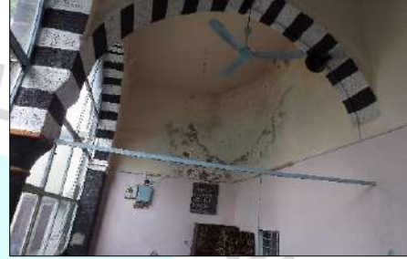
Şekil 11. Hoca Ahmet Camilerinde Neme Bağlı Oluşan Taşıyıcı Sistem Hasarları ve Taşıyıcı Sistem Hasarları
