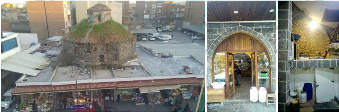
Şekil 2. Melik Ahmet Paşa Hamamı dış ve iç görünümü
