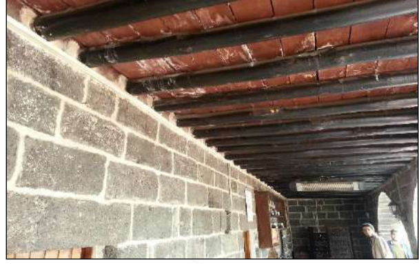
Şekil 29. Sülüklü Han'da Toprak Dam Kaybı Sonrası Betonarme Döşeme Yapılmasına Bağlı Sehim Hasarı
