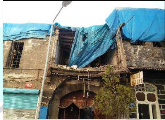
Şekil 30. Çifte Han'da Toprak Dam Kaybı ile Batı Girişindeki Ahşap Çatkılı Duvar Kaybına Bağlı
