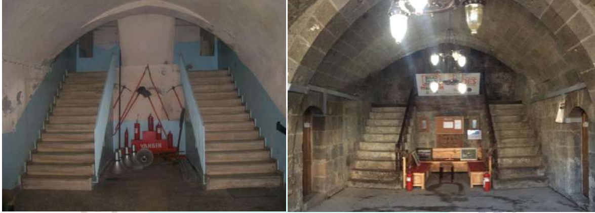
Şekil 5. İç sofadan üst kata çıkışı sağlayan üç kollu merdiven(2006 / 2017)
