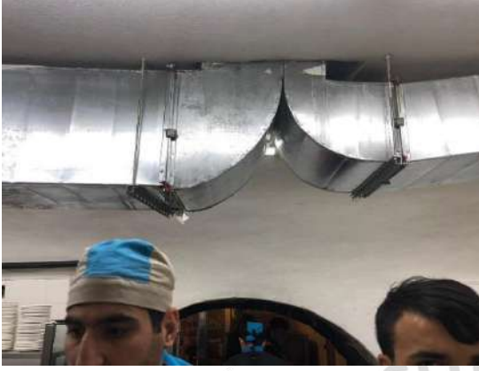
Fotoğraf 33: Mutfakta bulunan baca sistemi
