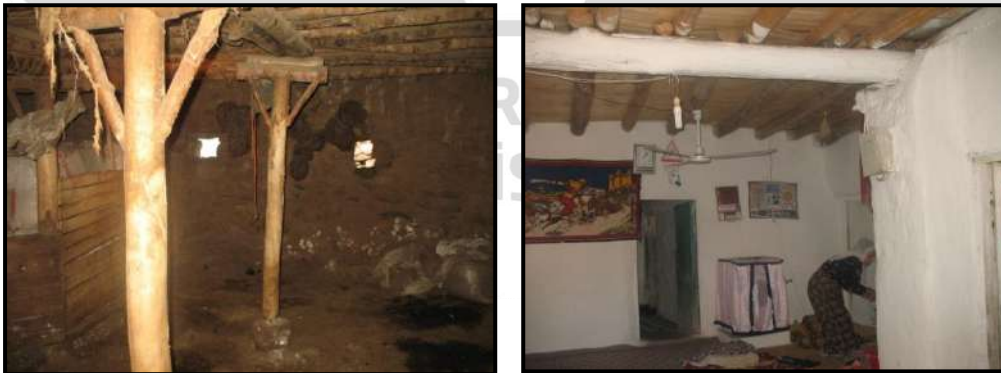
Şekil.2.9 Ahır mekânlarında ahşap kirişleme kullanımı
