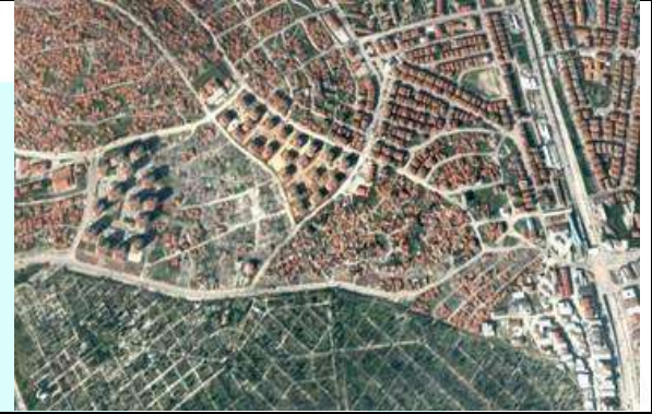
2011- Konut yapımı ve iç yollar tamamlandı.
