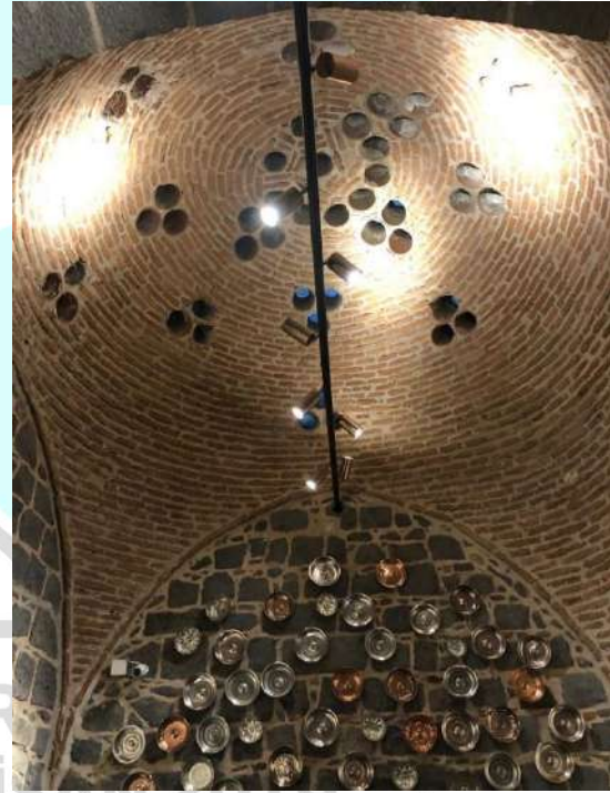
Fotoğraf 12:Ilıklık kubbesindeki fil gözü pencereler
