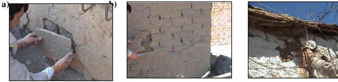
Şekil.5. Numune Alma a) Kuzey Cephesi b) Doğu Cephesi c) Güney Cephesi
