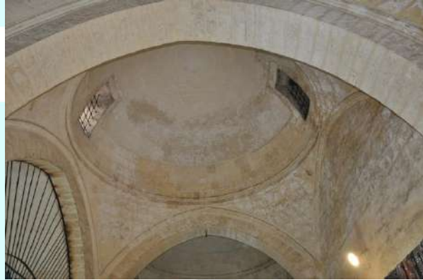
Şekil 7. Kubbenin içten görünüşü
