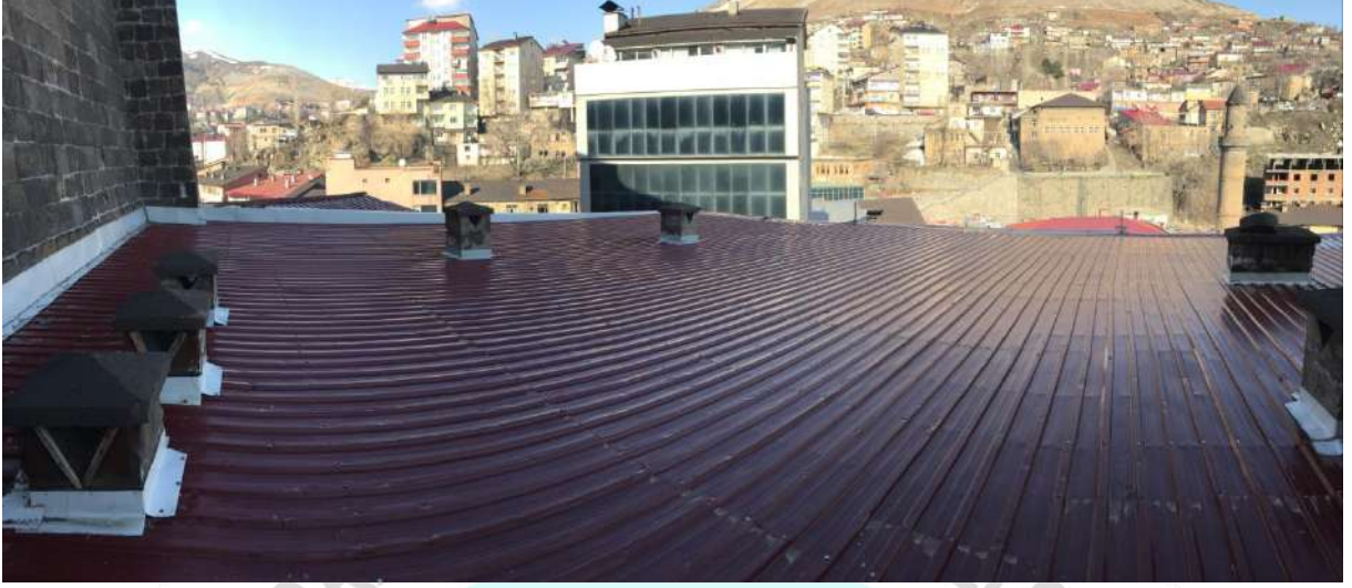
Şekil 7. Restorasyon sonrasındaki eğimli çatı görüntüsü(2017)
