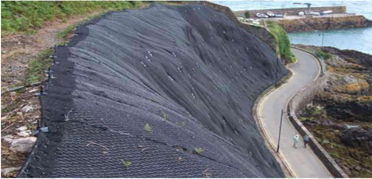
Şekil 5. The bitümlü ağ jeo bariyer, bitüm tablalar; sel anında kaymaya ve erozyona engel tedbirler
