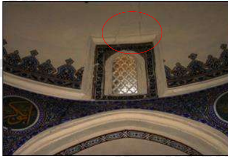
Şekil 7. Melik Ahmet Camii Kubbesinde Zemine Bağlı Oluşan Çatlak Hasarları
