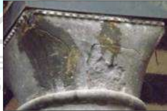
Şekil 21. Hasan Paşa Hanı Batı Revakındaki
