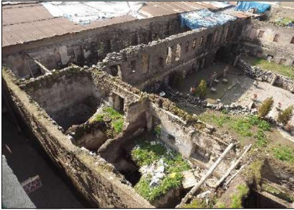
Şekil 30. Çifte Han'da Toprak Dam Kaybı ile Batı Girişindeki Ahşap Çatkılı Duvar Kaybına Bağlı
