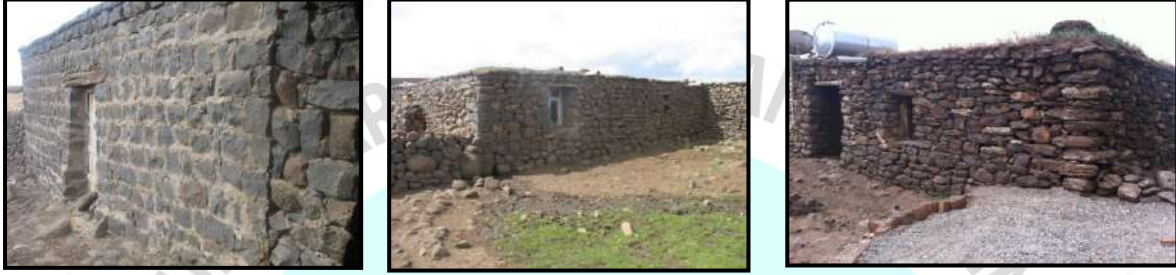
Şekil.2.1 Taşın kaba yonu, moloz, kuru örgü kullanımı (Diyarbakır)
