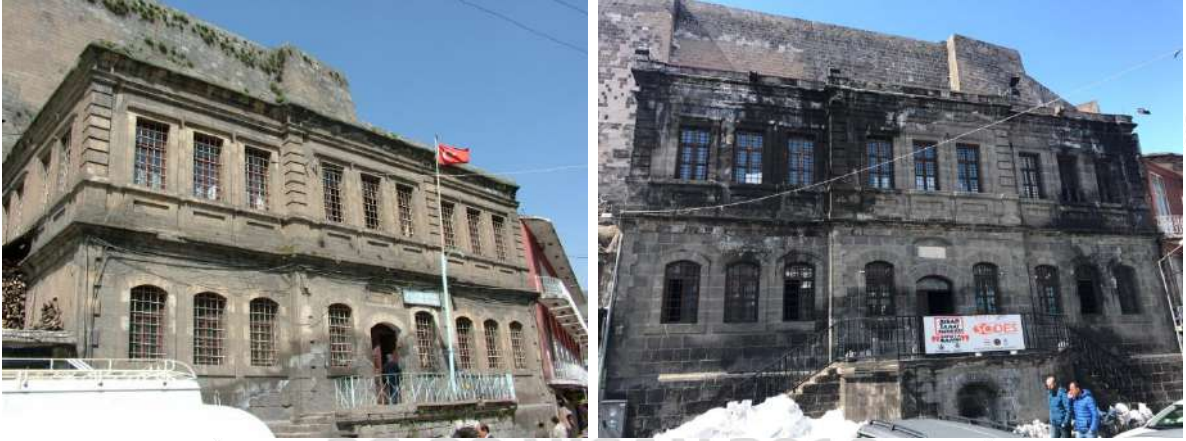
Şekil 8. Şarbaylık binası doğu cephesi restorasyon öncesi/ 2006 ve restorasyon sonrası/2017 durumu
