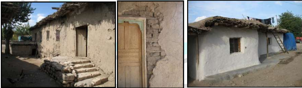
Şekil.2.4 Kerpiç yapılarda toprak sıva kullanımı (Diyarbakır, 2012)
