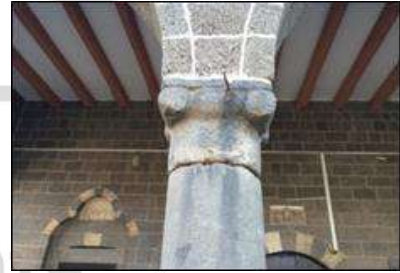
Şekil 13. Ali Paşa Camisinde betonarme döşeme etkisiyle oluşan kayma hasarları
