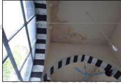
Şekil 12. Hoca Ahmet Paşa Camideki beton döşemeye bağlı oluşan hasarlar
