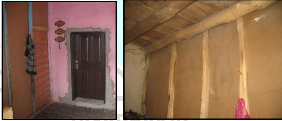
Şekil.2.11 Bölücü duvar olarak ahşabın kullanımı
