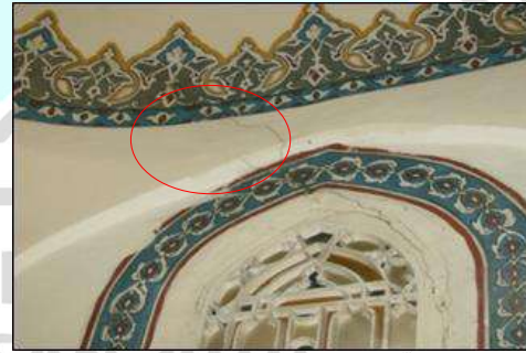
Şekil 7. Melik Ahmet Camii Kubbesinde Zemine Bağlı Oluşan Çatlak Hasarları
