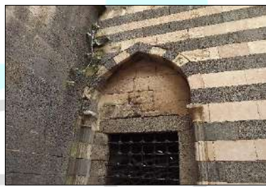
Şekil 19. Hoca Ahmet Camisinde Bakımsızlığa Bağlı Oluşan Nem ve Ayrışma Hasarları
