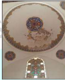
Şekil 11. Hoca Ahmet Camilerinde Neme Bağlı Oluşan Taşıyıcı Sistem Hasarları ve Taşıyıcı Sistem Hasarları
