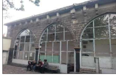
Şekil 6 Üst Örtüsü betonarme ile değiştirilen Hoca Ahmet Camii (Ayn Minare) 2019
