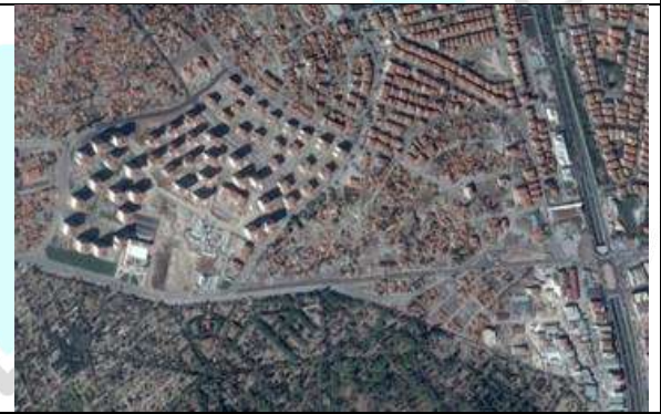
2013-Konut yapımı tamamlandı
