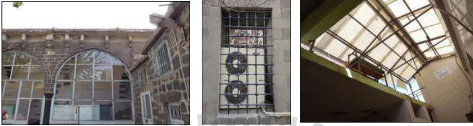
Şekil 17. Hoca Ahmet, Nebi Camilerinde Kullanıcı Kaynaklı Hatalı Uygulamalar
