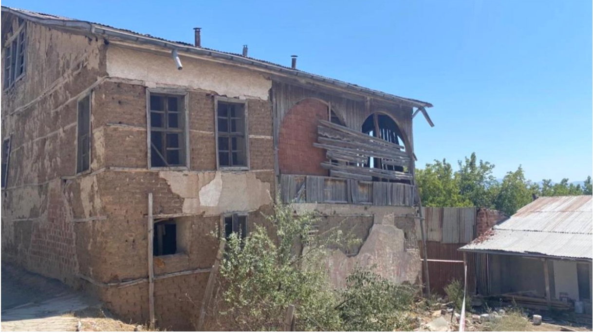
Şekil 3. Ferit Bey Konağı Genel görünüm
