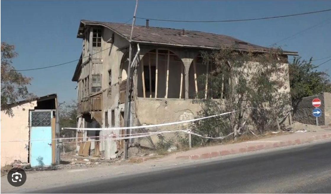
Şekil 4. Ferit Bey Konağı Genel görünüm
