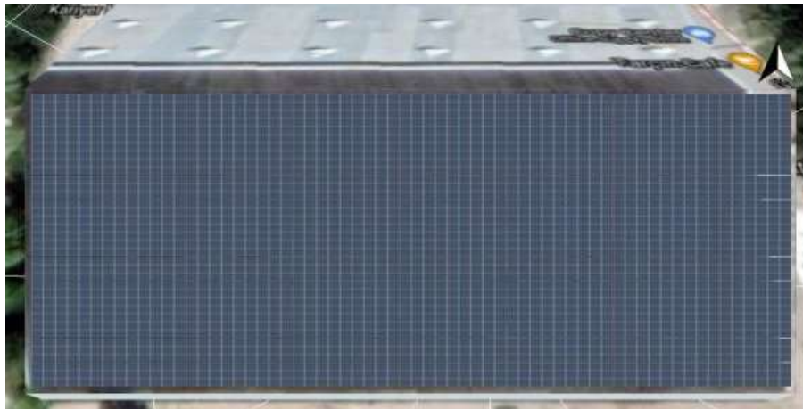
Görsel 14. PV Panellerin Güney Cephesine Konumlandırılmış Hali
