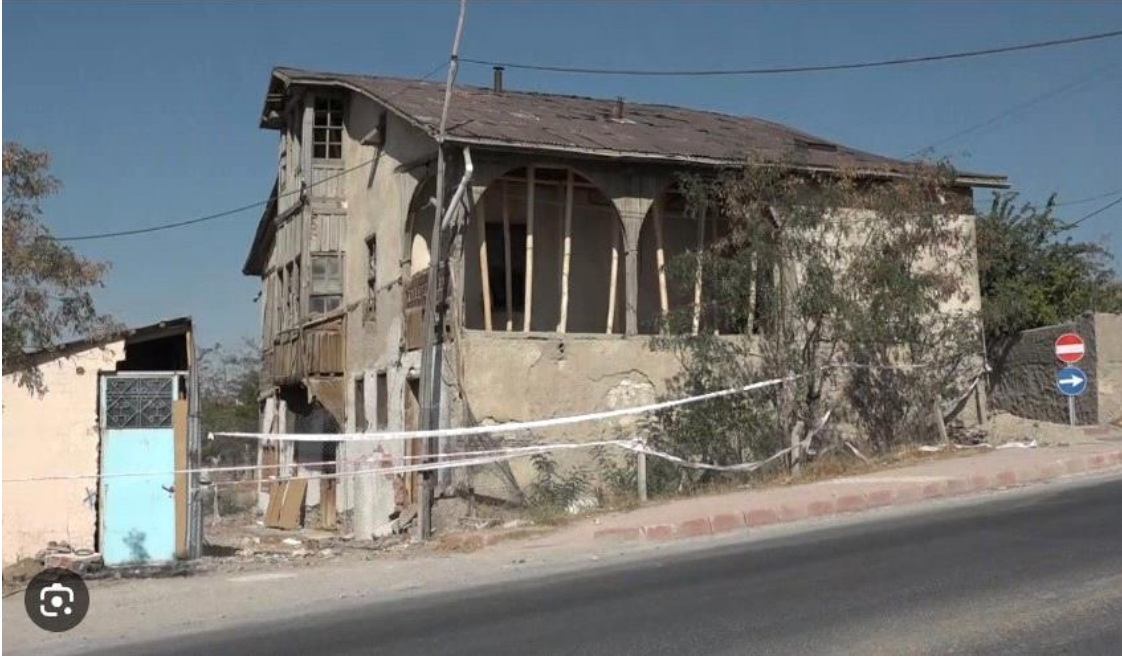
Şekil 4. Ferit Bey Konağı Genel görünüm
