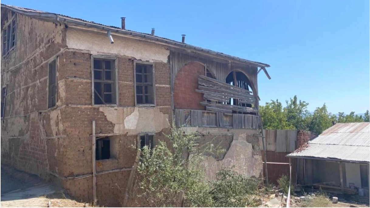
Şekil 3. Ferit Bey Konağı Genel görünüm
