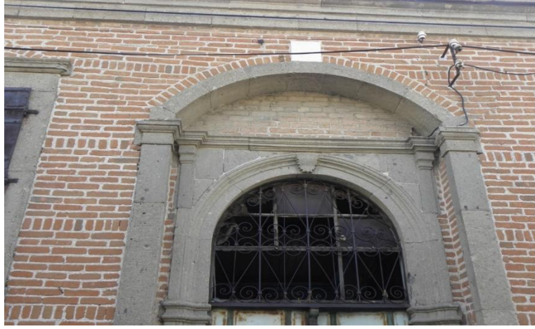
Fotoğraf:3- Ahmet Dalgıç Konağı Giriş Detayı.
