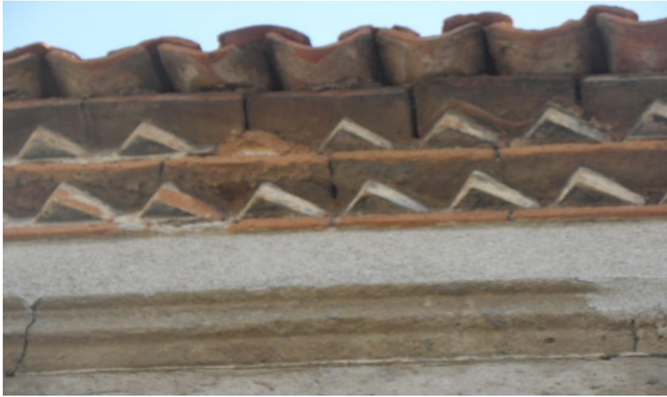
Fotoğraf:9- Hakkı Öktem Konağı'nda Yatay Profil Kuşağı ve Kirpi Saçak Uygulaması.
