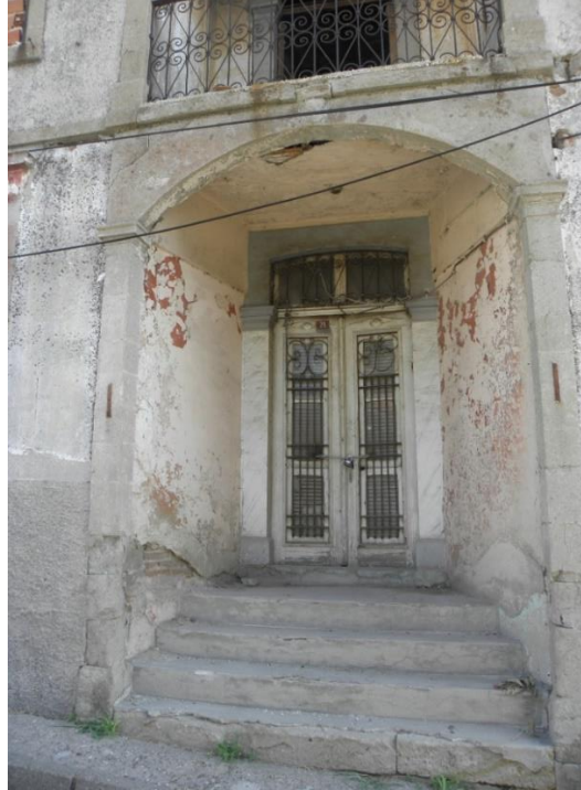
Fotoğraf:3- Hakkı Öktem Konağı Giriş Eyvanı.
