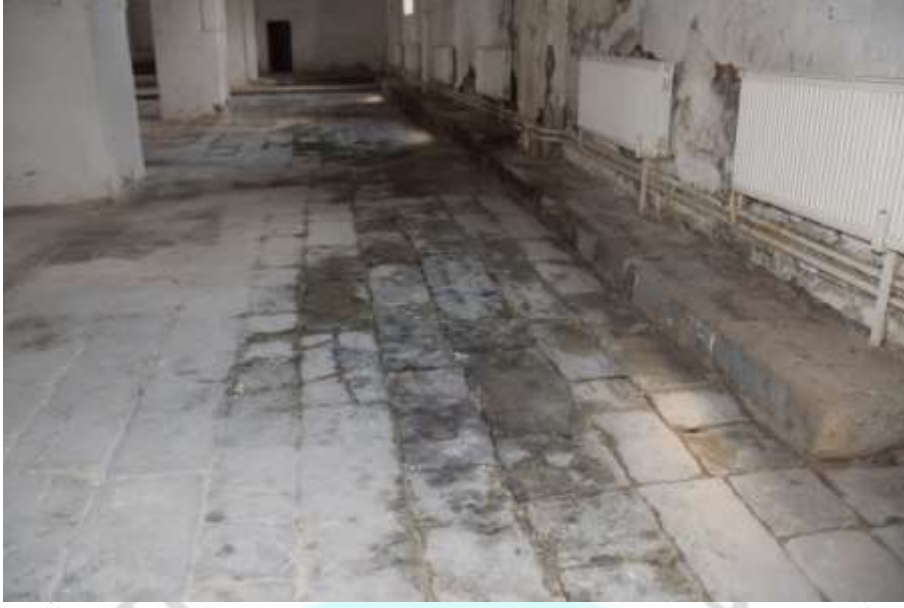
Görsel-20: Zeminde kullanılan doğal taşa görülen renk değişimleri ve ısıtma donanımı (Bülent Ayberk ve Komd.Tug.K..ılığı Foto Film Merkezi – 2019)
