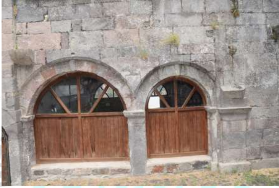
Görsel-11: Şapelin güney duvarında bulunan, kemerlerin üzerine oturduğu bingiler (Bülent Ayberk ve Komd.Tug.K..ılığ Foto Film Merkezi – 2019)
